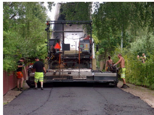
På bilden ser vi hur i augusti Alvägen beläggas med asfalt.
